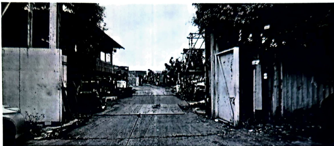
照片為大門出入口處之有蓋排水渠 (< c )
